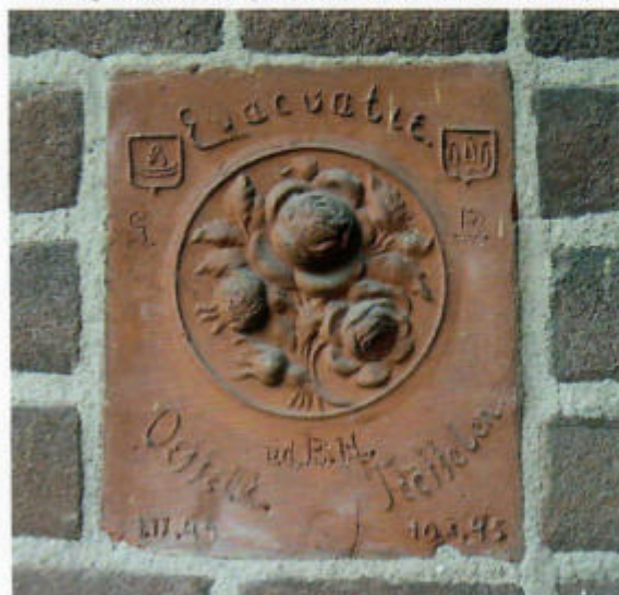
Steen gemetseld in het portaal van het woonhuis Boxenhof
