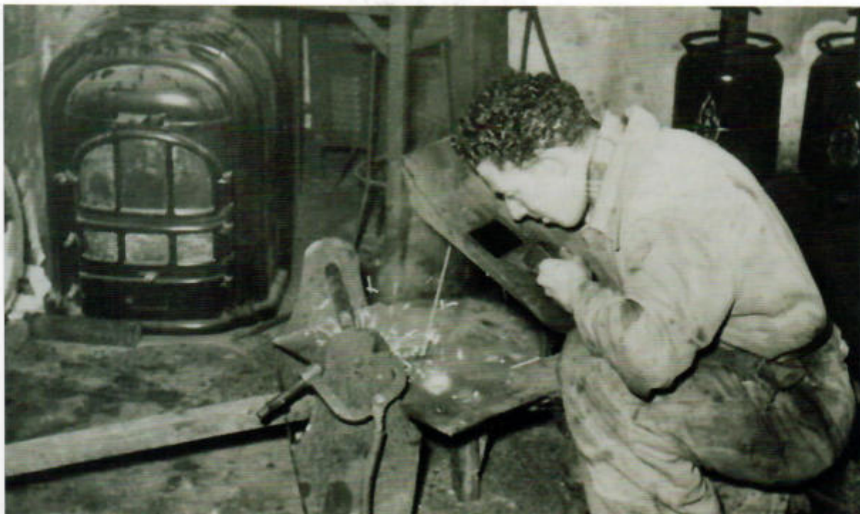
Tinus aan het lassen in zijn werkplaats
